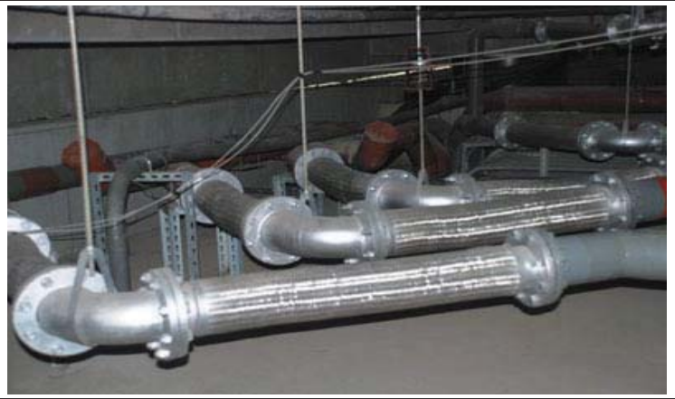
Fig. 2: 直式配管配管實例。
